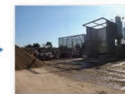
造粒固化施設
